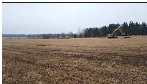
Figur 3. Vy över det västra området från nordväst. Schaktgrävning pågår på den plana, högre belägna delen i väster.
