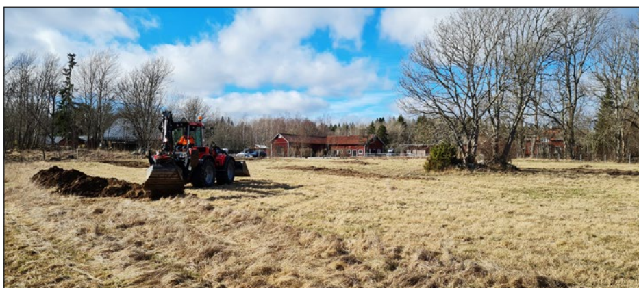
Figur 4. Vy över utredningsområdet från sydväst vid pågående schaktning.
