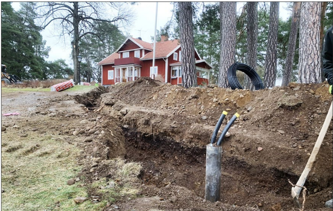
Figur 8. Schaktet med A3 synligt i schaktväggen. Foto från sydväst.
