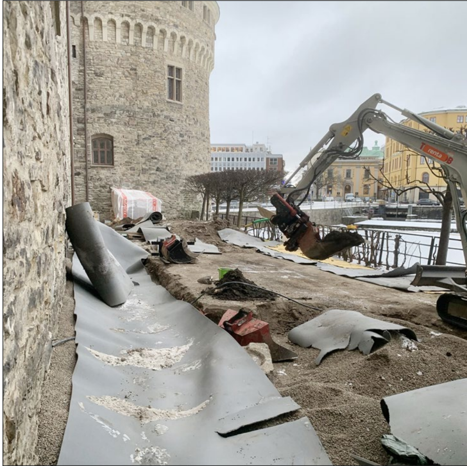
Figur 3. Arbete pågår. Foto från norr.
