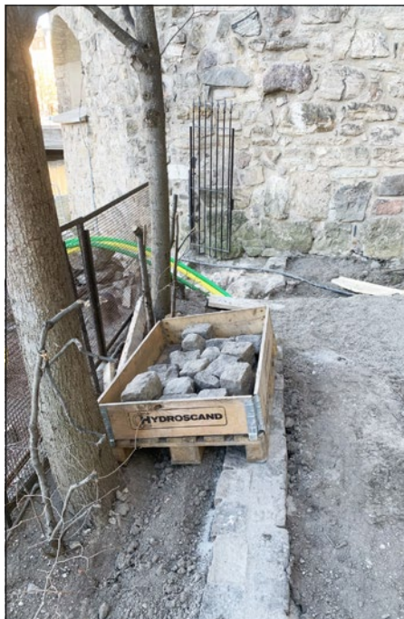
Figur 11. Murens läge markeras av en stenläggning i det nya ytskiktet på terrassen.
