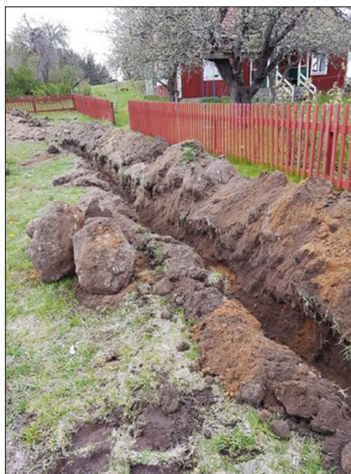
Figur 10. Schaktning längs med Mellangården. Sett från öster.
