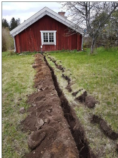
Figur 9. Anslutningsschakt med Lillgården i bakgrunden. Sett från öster.
