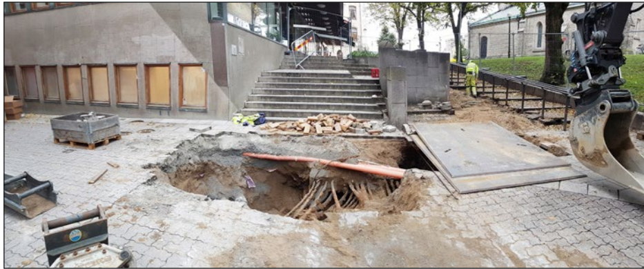
Figur 6. Schakt 1 sett från väster, korsningen Ågatan/Vasagatan. I högra delen av bilden syns det förberedande arbetet med att plocka bort trappstenar från "Vasatrappen".
