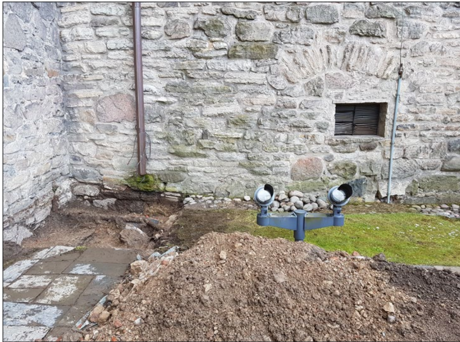
Figur 10. Schaktet grävdes i hörnet intill det sydvästra tornet och det västra murlivet någon meter ifrån den sedan tidigare igenmurade öppningen. I schaktet syns den nedgrävda ledningen.
