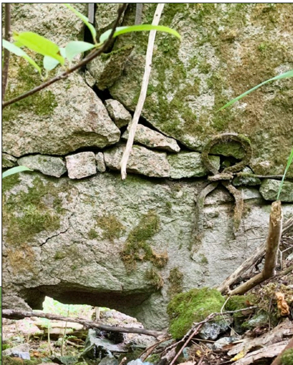
Figur 22. Detalj ur smedjegrundens vägg med ankarjärn för att hålla ihop de breda väggarna. Mellan de större stenarna är mindre skolstenar för att kila fast de större stenarna. Foto från nordöst.
