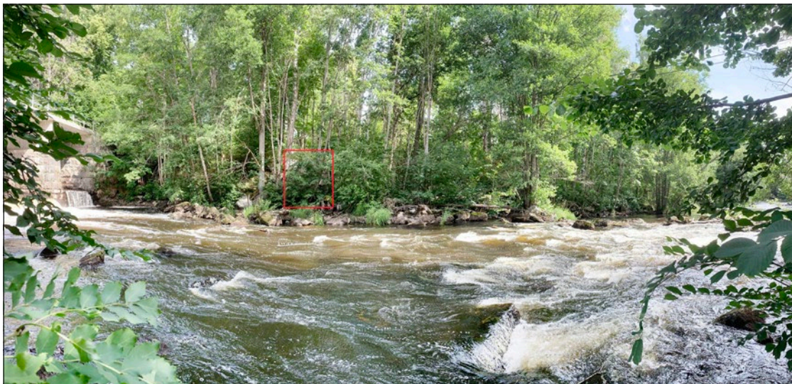
Figur 11. I bildens vänstra del ses Smedjefallsdammen. Röd ram markerar läget för brofästet (objekt 1). Foto från sydväst.
