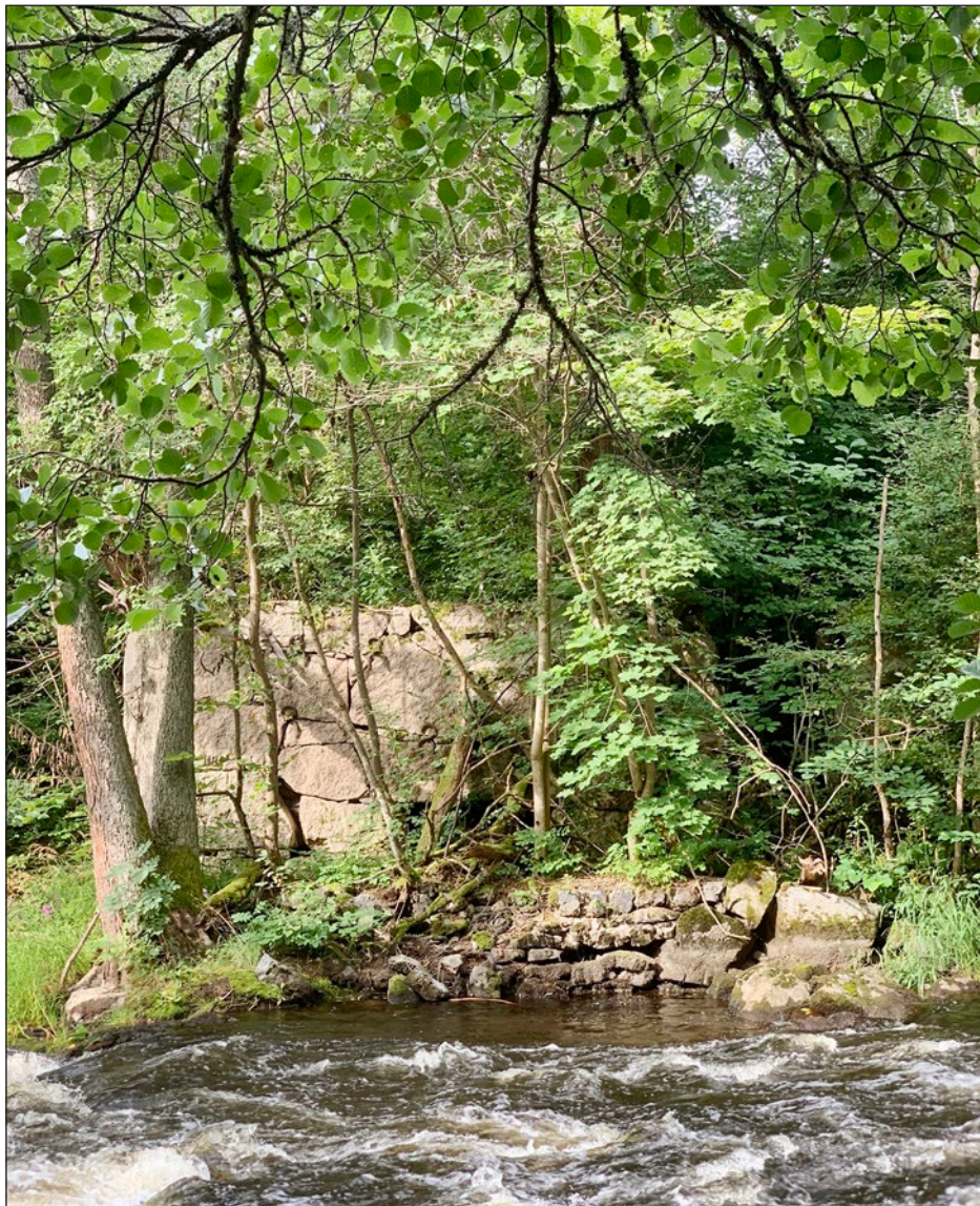
Figur 20. Smedjan (objekt 12) och hjulgravens stödmur (objekt 11) sedd från norra åkanten. Stödmuren är anlagd i å medan den 3 meter höga smedjebyggnaden ses i bakgrunden uppförd vid åkanten.
