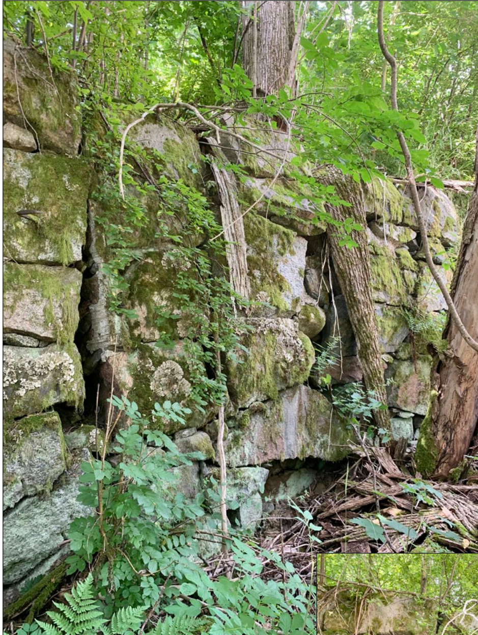
Figur 18. Del av brofästet sedd från sydöst. Observera den tydliga skarven gentemot smedjan (objekt 12) till vänster, vilket antyder att smedjan är tillkommen vid ett senare tillfälle.
