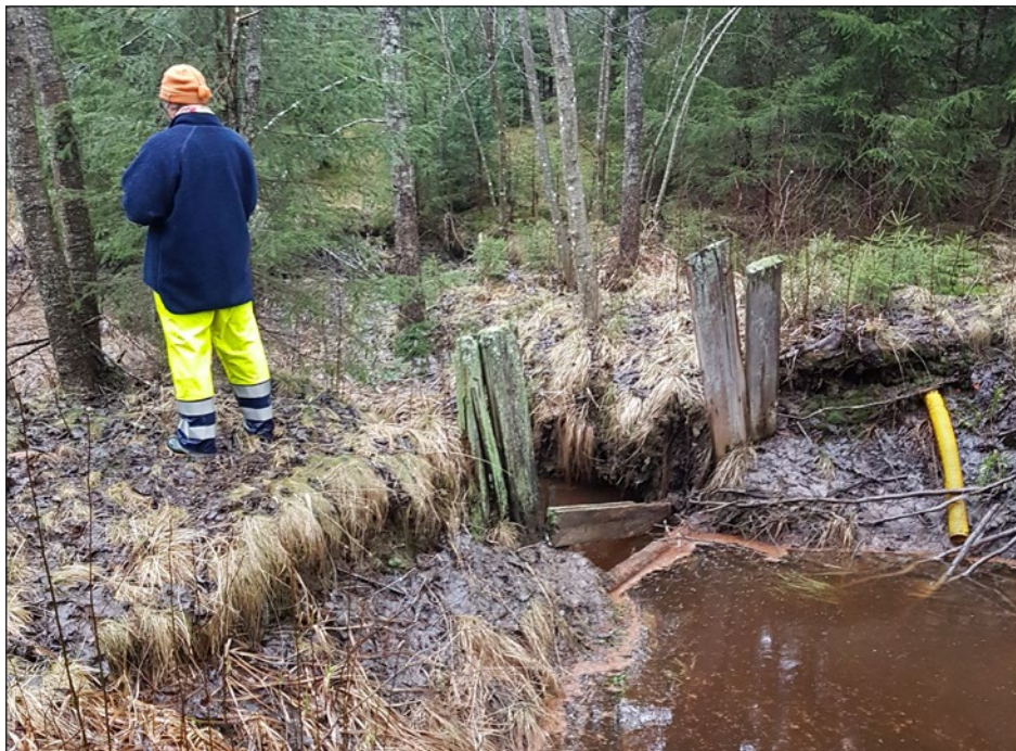
Figur 24. Dammvall (objekt 34) som dämt upp äldre naturligt flöde sedan man grävt genom slingrande meandrar för att erhålla en mer rät riktning på åns flöde. Foto från öster.
