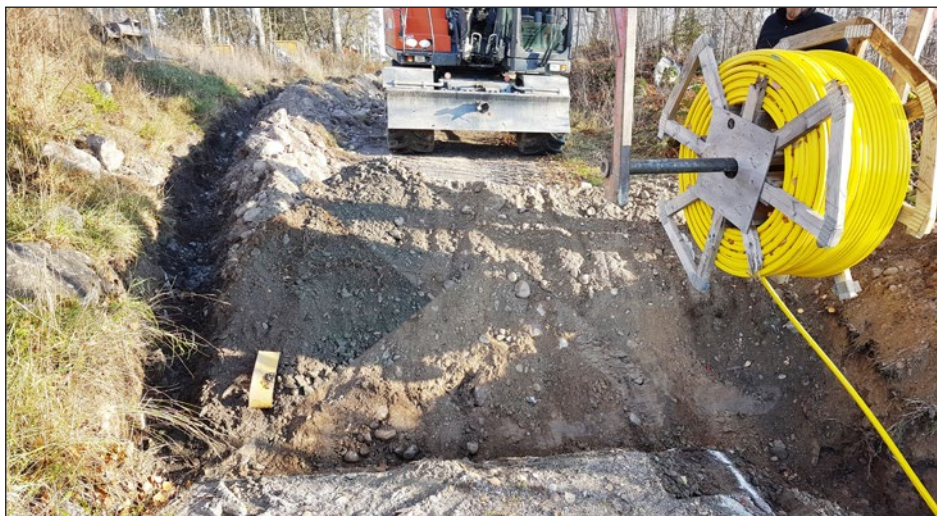
Figur 4. Här syns schakt 1 till vänster i bild och schakt 2 som grävdes tvärs genom vägen och vidare till en tomtgräns. I schaktets vänstra del syns ett gult band som markerar läget för en elkabel och VA-ledning som tidigare grävts genom vägen. Schakt 1 löpte parallellt med denna äldre ledningsgrävning och grävdes norr om den. Foto från väster.
