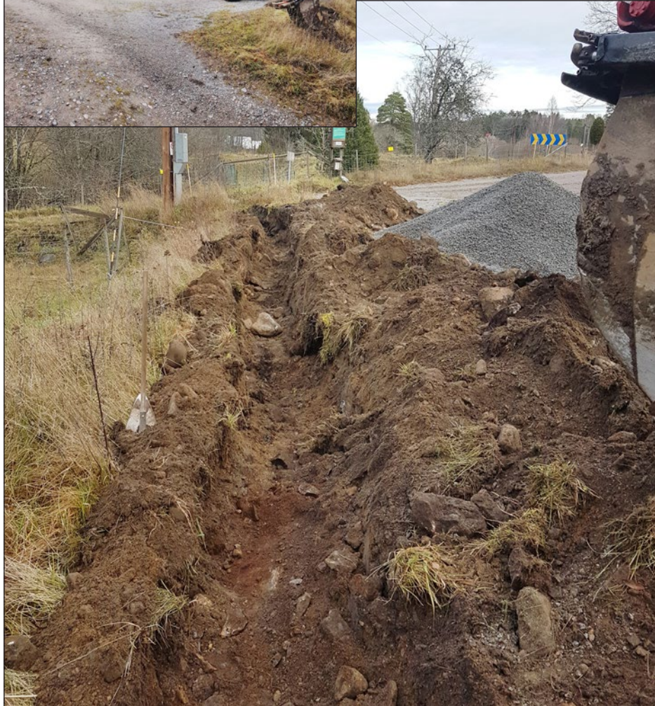
Figur 9. I schakt 5 påträffades bärlager överst med malmsten i botten. Foto från söder.
