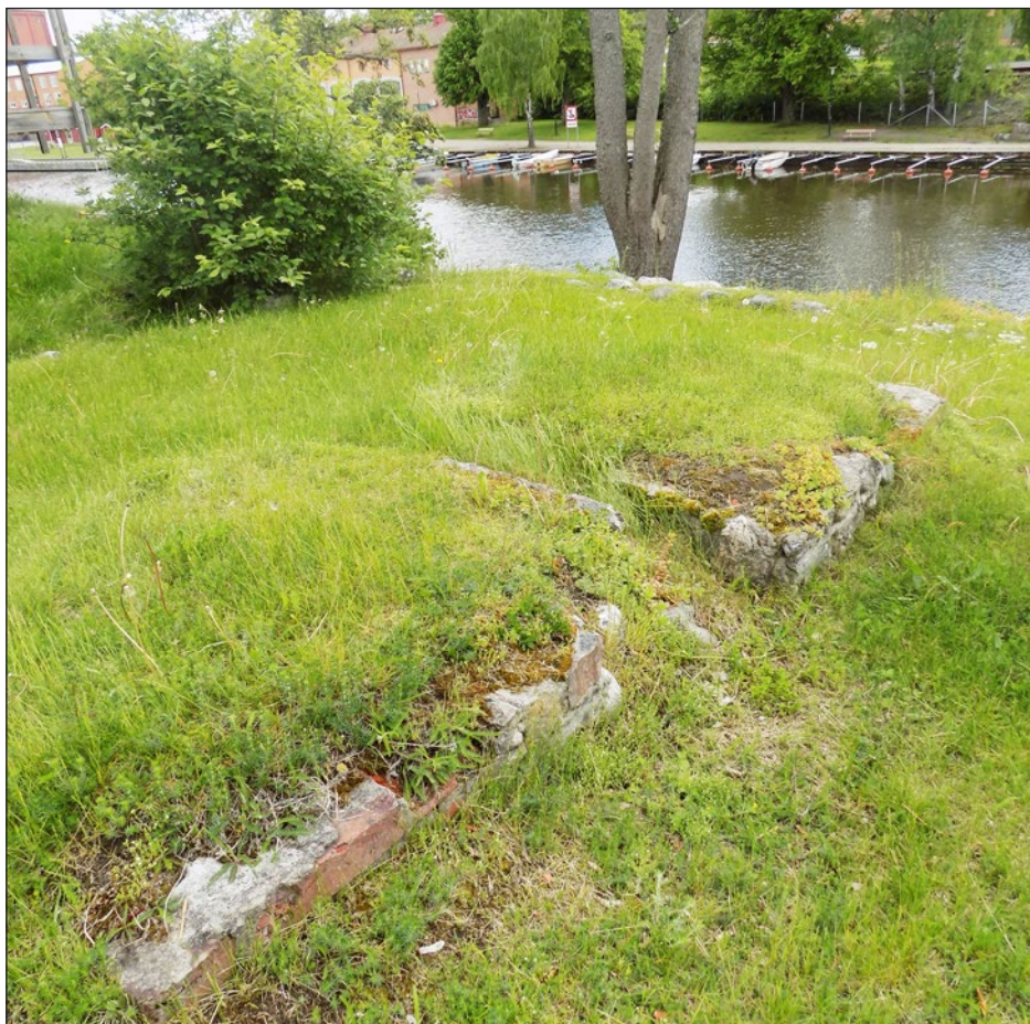
Figur 38. Rådsbyggnaden med fundament och innerväggar. Foto från nordväst.
