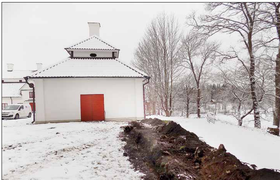
Figur 5. Schaktet framför köksflygeln. Foto taget från öster.
