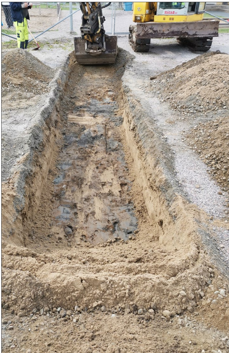
Figur 4. Schakt 1. Foto från norr.
