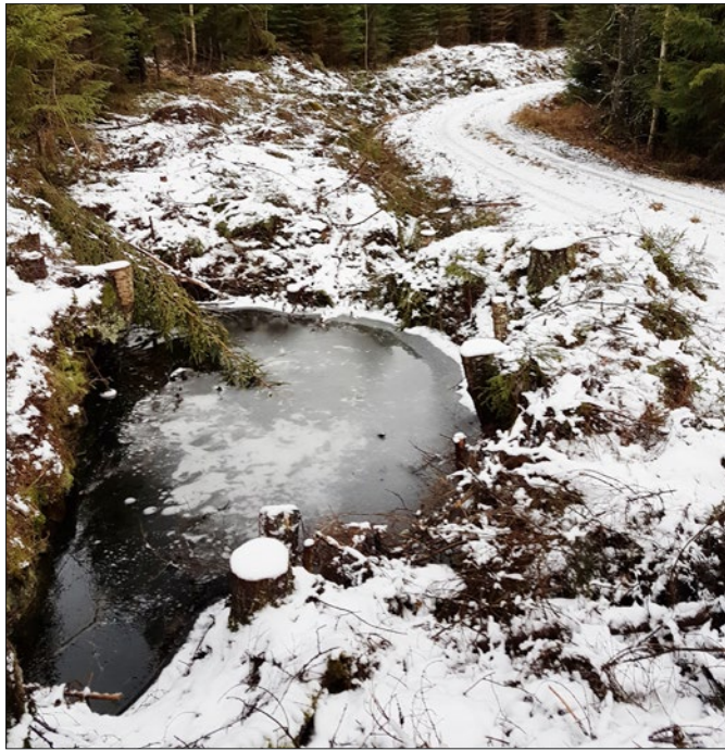
Figur 9. Gruvhål A27 sett från norr med avverkad skog som markerar plats där ledningssträckan skulle grävas. Ledningen skulle grävas i dikesrenen öster om grusvägen.
