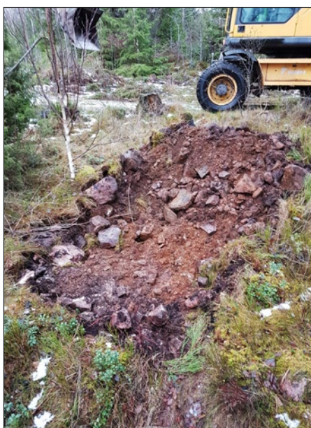
Figur 18. Schakt 9 utgjordes av varpsten som fanns som ett 0,1 meter tjockt lager i schakt 8, 9 och 10. Foto från sydväst.
