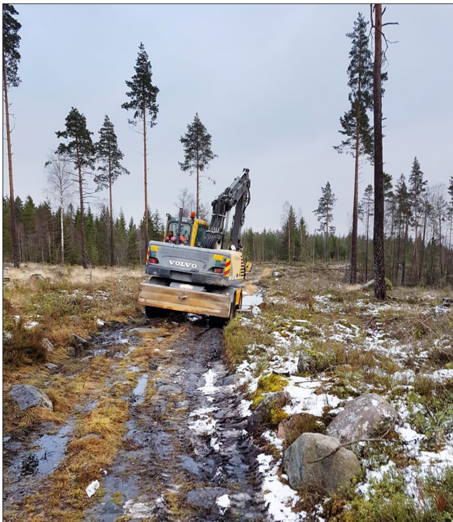
Figur 5. Inför kabelgrävningen utförde en arkeolog och grävmaskin undersökningen och grävde utvalda platser längs de berörda gruvområdena. Foto från norr.
