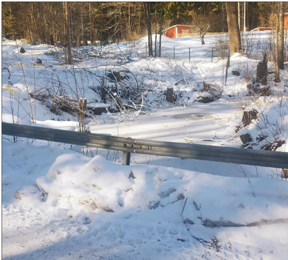
Figur 3. Översikt innan schaktningen påbörjades. Foto från söder.
