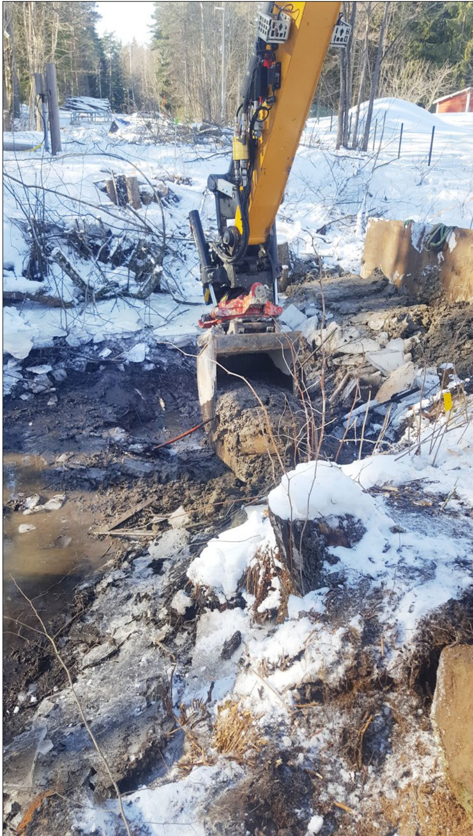
Figur 4. Inledande schaktningsarbeten. Foto från sydöst.
