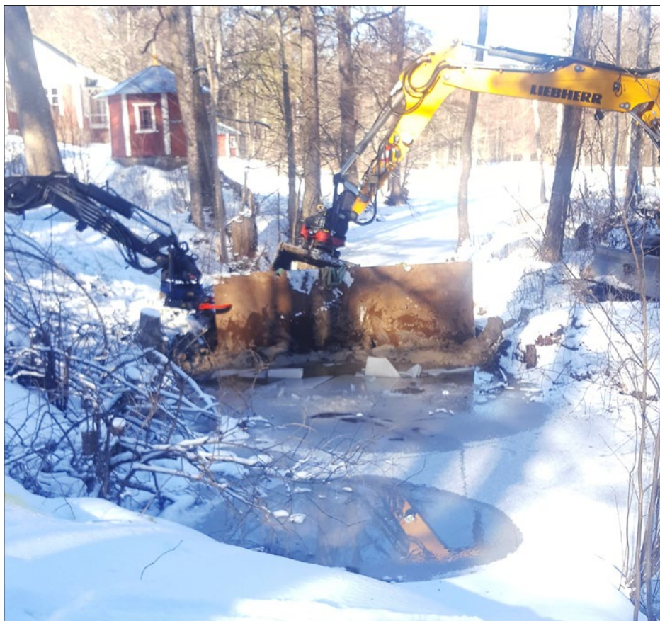
Figur 6. En tillfällig spånt trycks ner i vattendragets leriga botten. Foto från sydväst.
