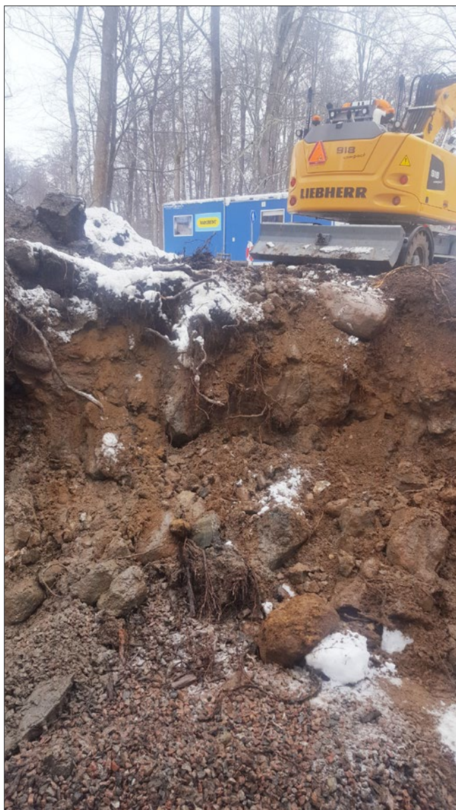
Figur 7. Schaktväggen med omrörda massor. Foto från väster.
