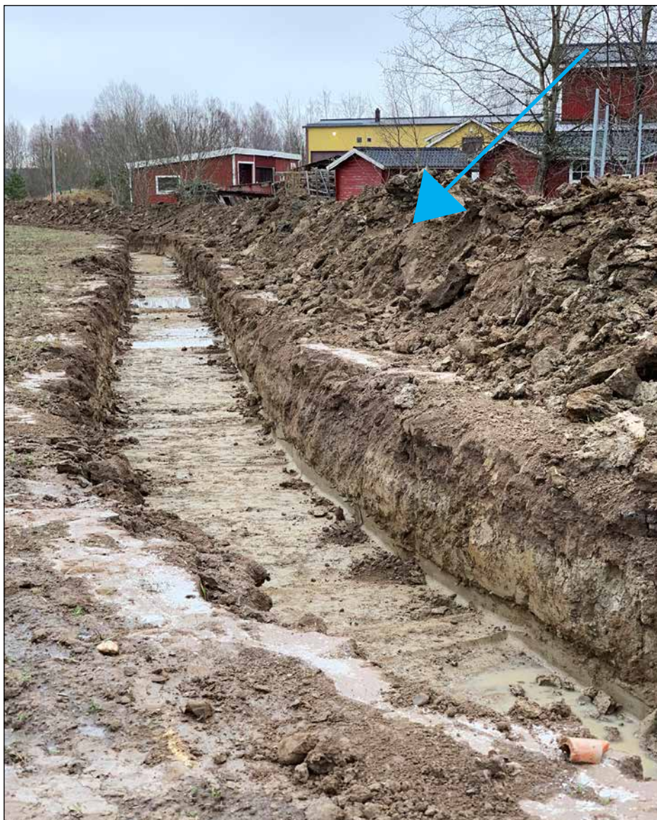
Figur 3. Schaktet sett från väster. Kvarvarande del av högen L2002:6761 finns under huset markerad med blå pil.
