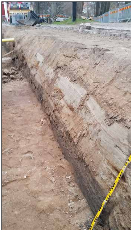
Figur 8. Del av schaktet i Trädgårdsgatan. I profilen syns naturligt avsatta sandlager under det moderna bärlagret. I schaktbotten syns ett lerigt lager som innehåller rikligt med organiskt material med bland annat avtryck från diverse växter.
