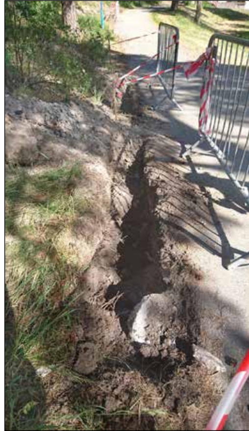
Figur 4. Foto över schakt 2.
