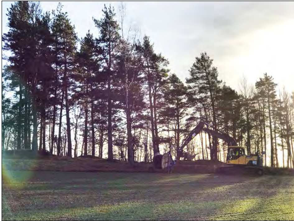
Figur 3. Schaktningsarbete pågår i närheten av Sköllersta 6:1. Foto från norr.
