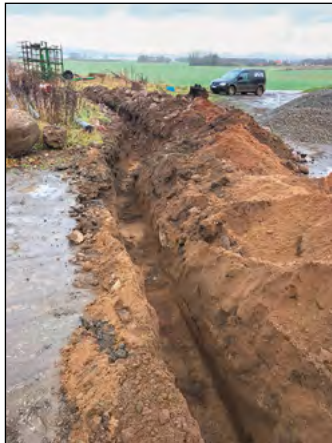
Figur 11. Översiktsbild. I norr löpte schaktet genom påförda massor (A21). Foto från söder.
