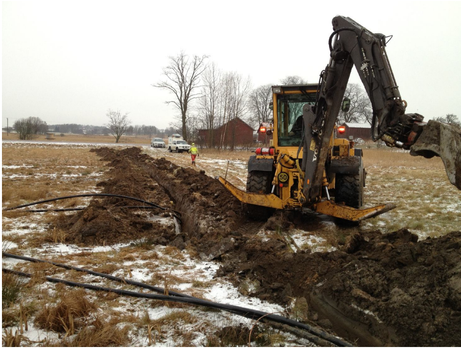
Figur 2. Schaktet på den norra sidan av motorvägen. Foto från söder av Leif Karlenby.
