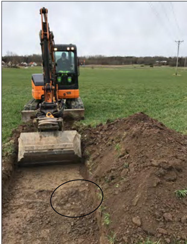
Figur 14. Schaktning pågå. Stolphålet A772 är markerat med en svart oval.
