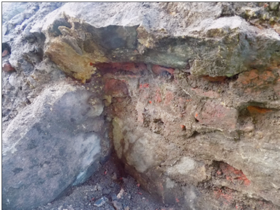
Figur. 4. Foto av sydvästra hörnet av källaren med en antydning till ett välvt tak. Sett från nordöst.
