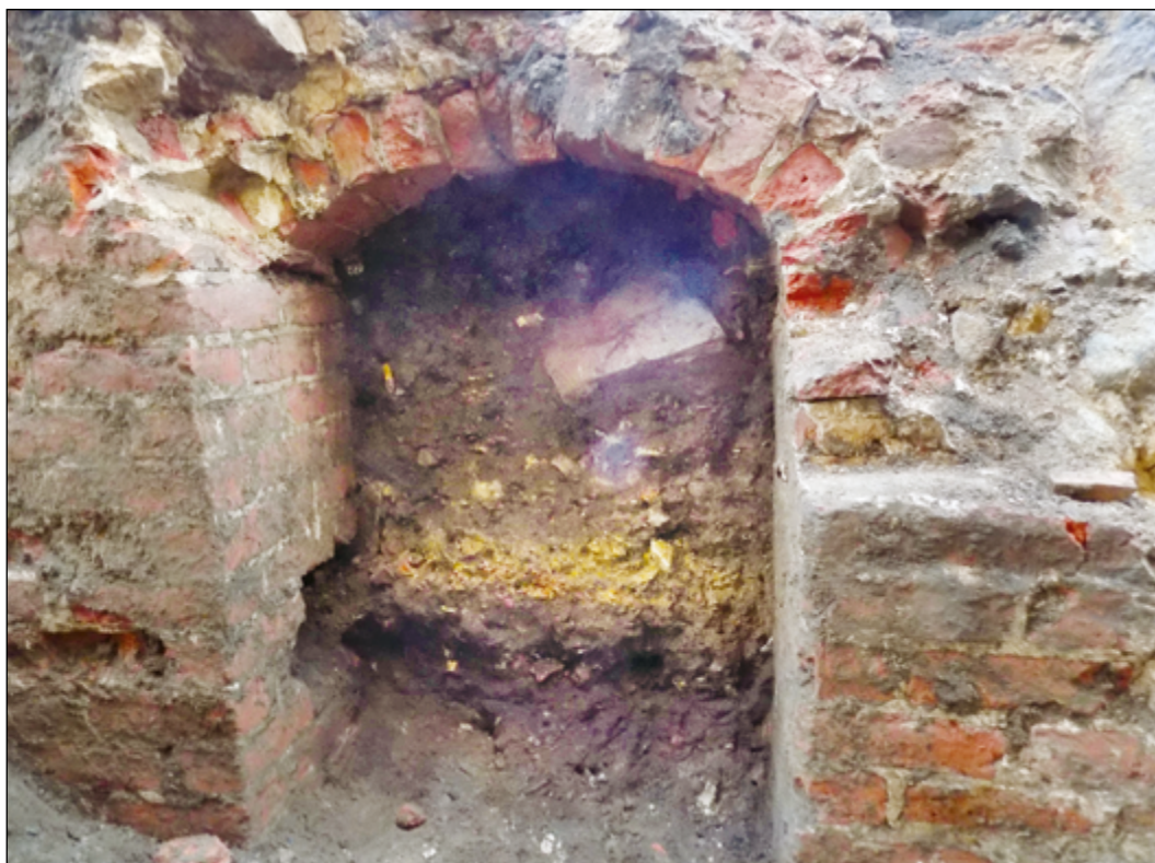
Figur 5. Tegelinfattad dörr. Foto från öster.
