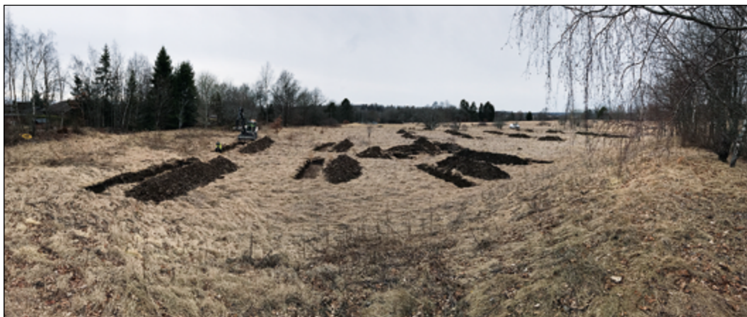
Figur 4. Vy över den östra delen av utredningsområdet med utredningsschaktning på gång. Området var till stora delar sankt och i norr (höger i bild) påträffades ett vatten-avsatt kulturlager (A507) som innehöll en del tegel och spik.
