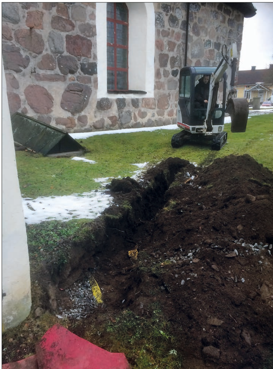
Figur 4. Schaktning pågår. Foto taget av Arkeologgruppen AB.
