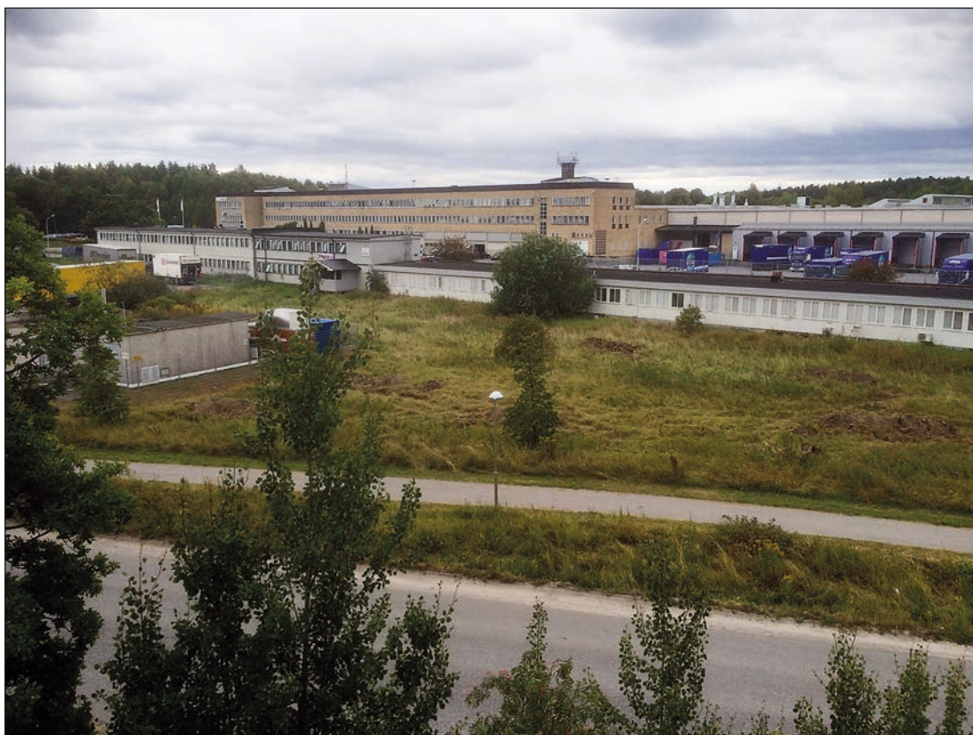
Figur 7. Objekt 35. Översikt över norra delen med Lintaverken i bakgrunden. Foto taget av Arkeologgruppen AB.
