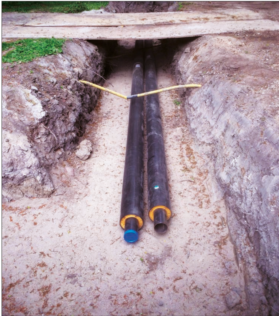
Figur 5. Rör på plats på utjämnade sandlager. Foto av Arkeologgruppen AB.
