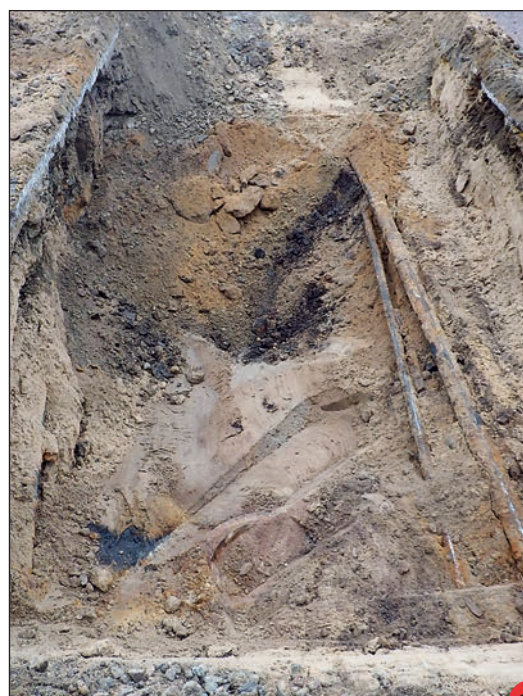
Figur 25. Saneringssand samt rör från oljetankarna i schakt 584. Foto av Arkeologgruppen AB.
