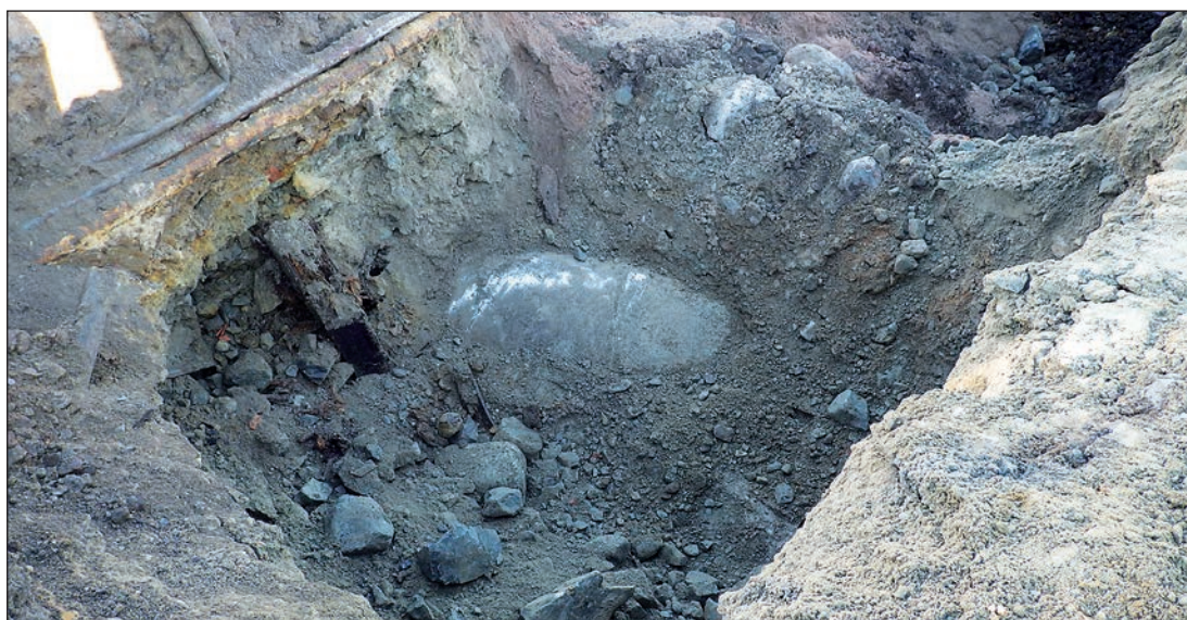
Figur 31. Kulverterad del av Gruvbäcken i schakt 609. Foto av Arkeologgruppen AB.
