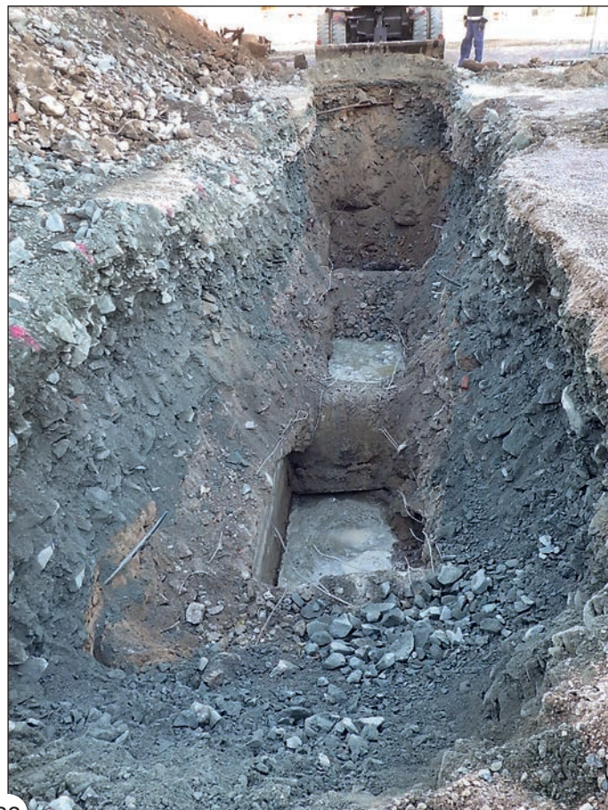
Figur 15. Här ses omfattningen av den påförda bergkrossen samt delar av de gjutna grunderna mot schaktets botten. Foto av Arkeologgruppen AB.
