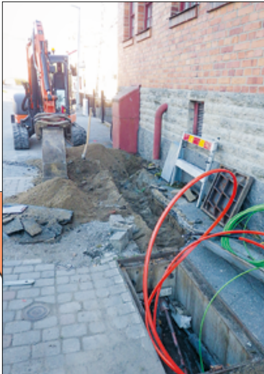
Figur 3. Schaktet grävdes vid Kristinaskolans norra fasad, invid östra hörnet. I bildens nedre del syns den befintliga kabelkanalisationen som kunde återanvändas vid resterande kabelarbete. Foto från nordväst av Johnny Rönngren.
