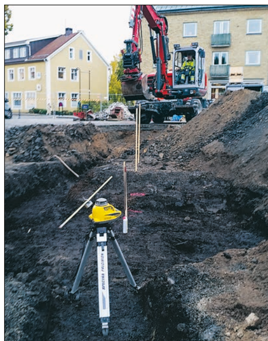
Figur 5. Arbetet utfördes i form av en schaktningsövervakning vilket innebar att en arkeolog övervakade arbetet då grävmaskin skiktvis grävde bort jord. Här har schaktningen av fontänen (S313) precis avklarats. Foto från norr av Johnny Rönngren.
