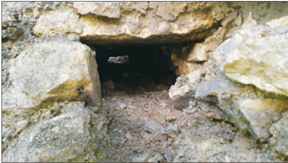
Figur 7. Bild på kulverten (A705) Foto från öster av Ebba Knabe.
