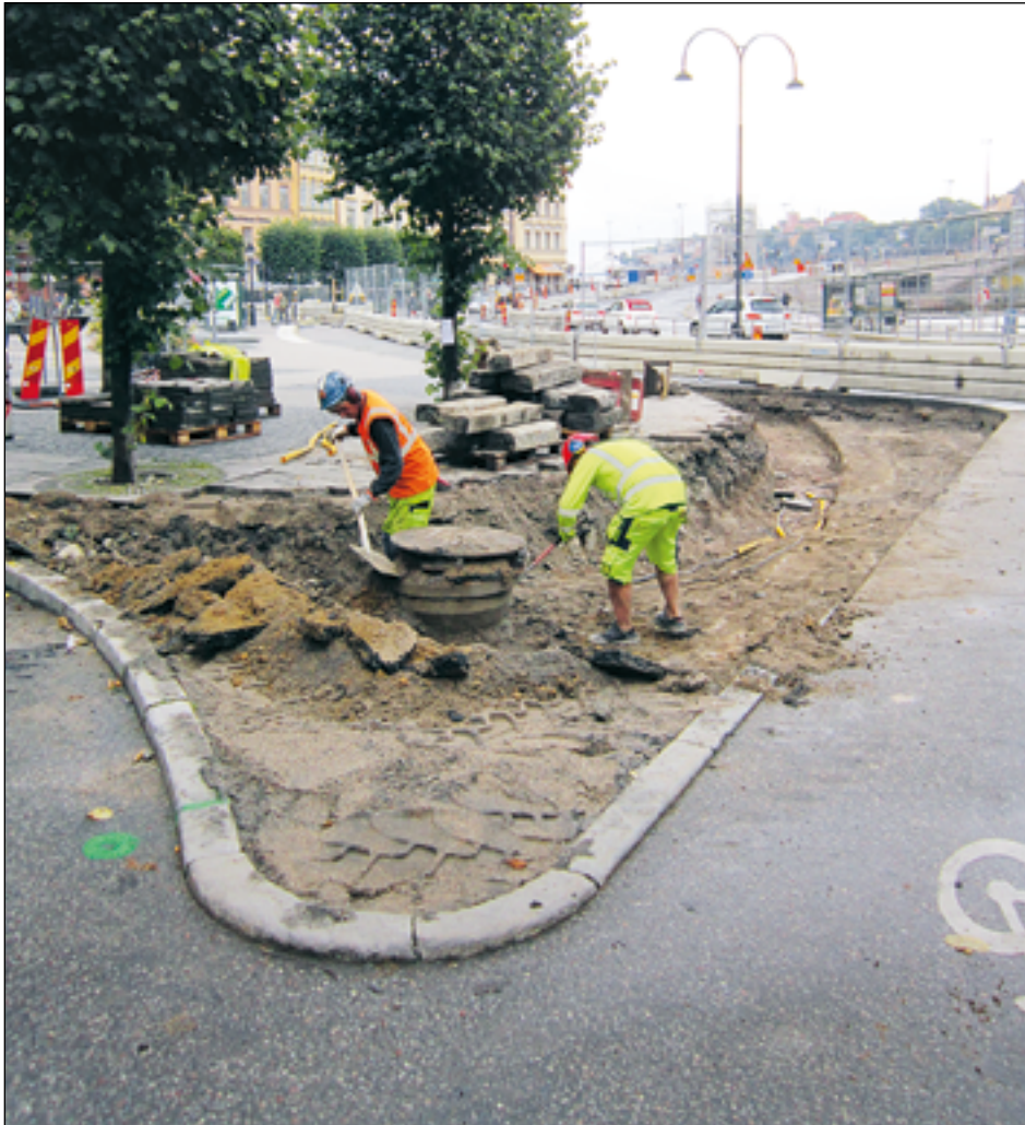
Figur 2. Friläggning av äldre regnvattenbrunn. Foto av Tomas Ekman.
