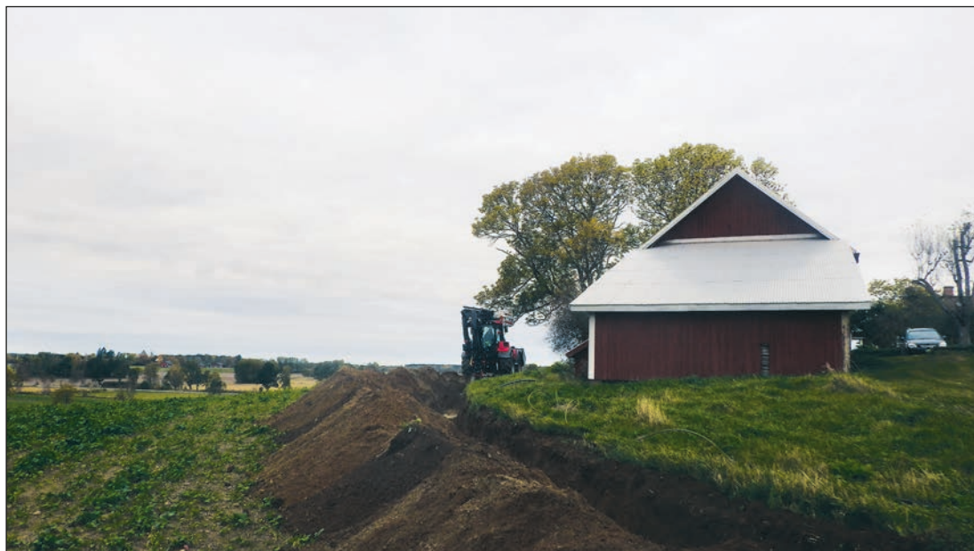
Figur 34. Södra delen av schaktet i Tarsta. Foto från norr taget av Ebba Knabe.
