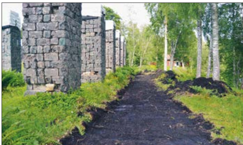
Figur 5. Schakt 1 med slaggstenspelarna. Foto från väster av Erica Strengbom.
