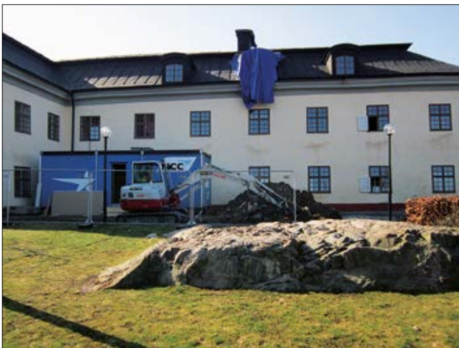
Figur 3. Existerande bergsklack och pågående schaktning. Foto av Tomas Ekman.
