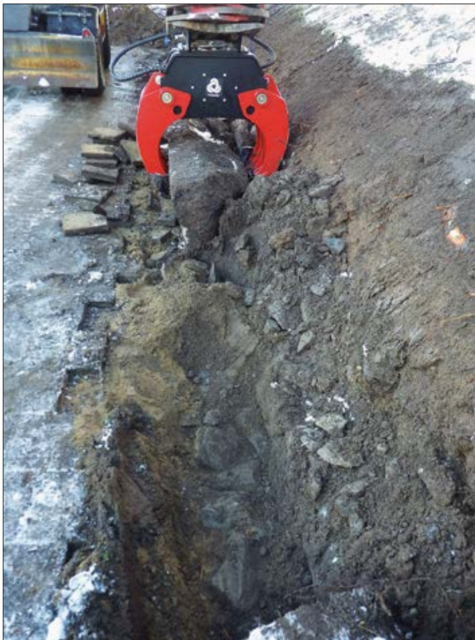
Figur 3. Maskinen i färd med att lyfta upp en mursten (A1). I bildens nedre del syns den stenpackning (A2) som låg under murstenarna. Mot slänten syns fyllningen som innehöll rikligt med sprängsten. Foto från öster av Johnny Rönngren.
