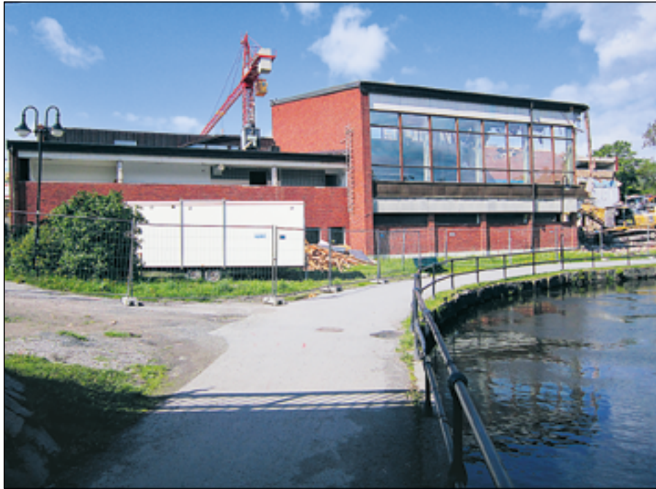
Figur 3. Badhuset under rivning. Foto från norr av Arkeologgruppen.
