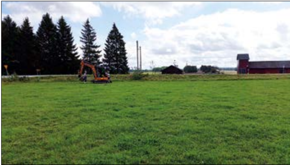
Figur 14. Schaktning invid Glanshammarsvägen inom objekt 19, norr om vägen. Foto från norr av Leif Karlenby.
