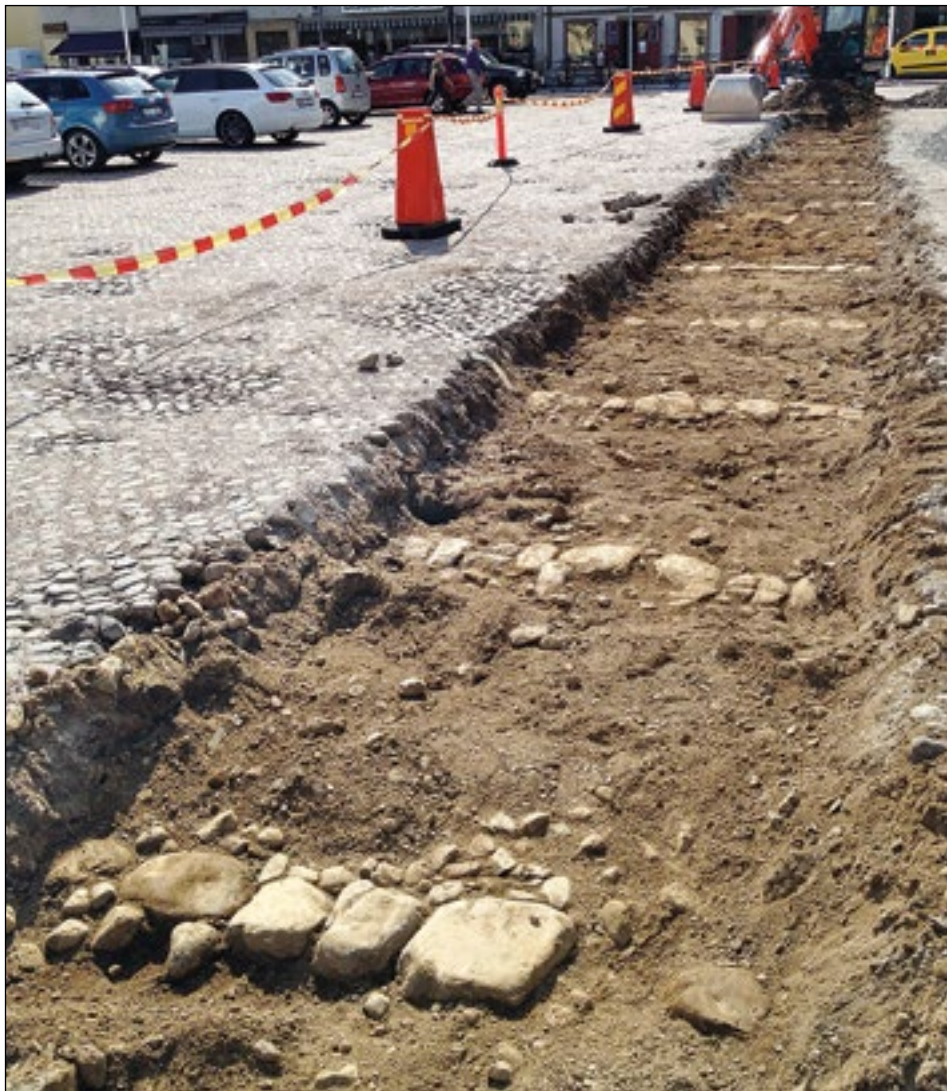
Figur 3. Vy över schakt 8784 från öster med raderna av större sten som ligger kvar från torg 2. Foto år 2012 av Leif Karlenby.
