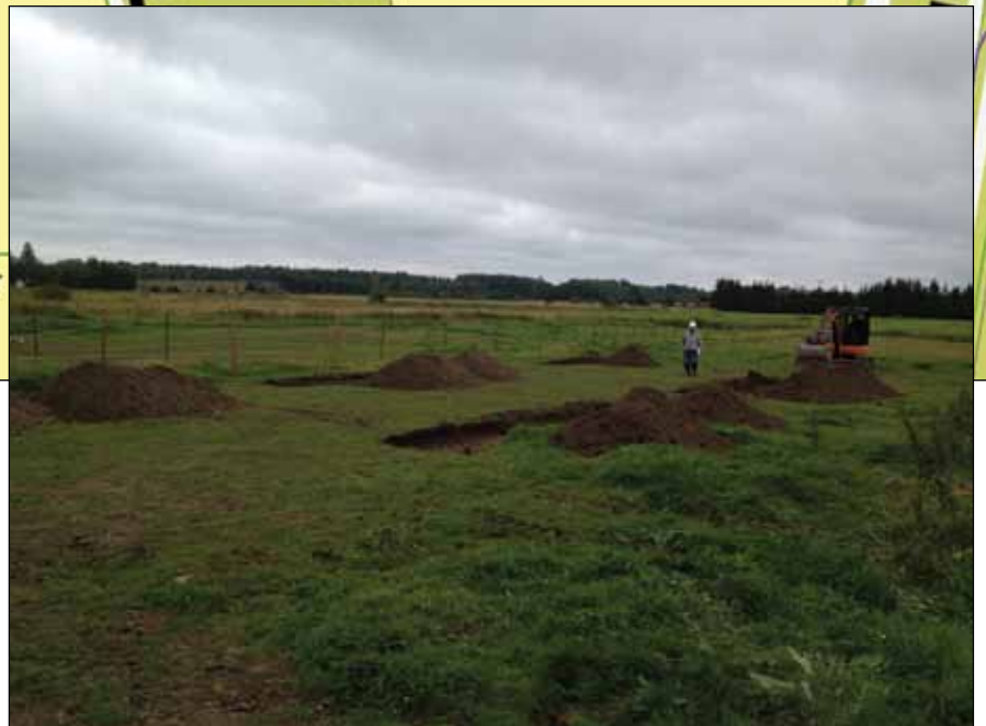
Figur 4. Vy över det södra området (alternativ B) från sydväst efter det att schakten grävts. Foto av Leif Karlenby.
