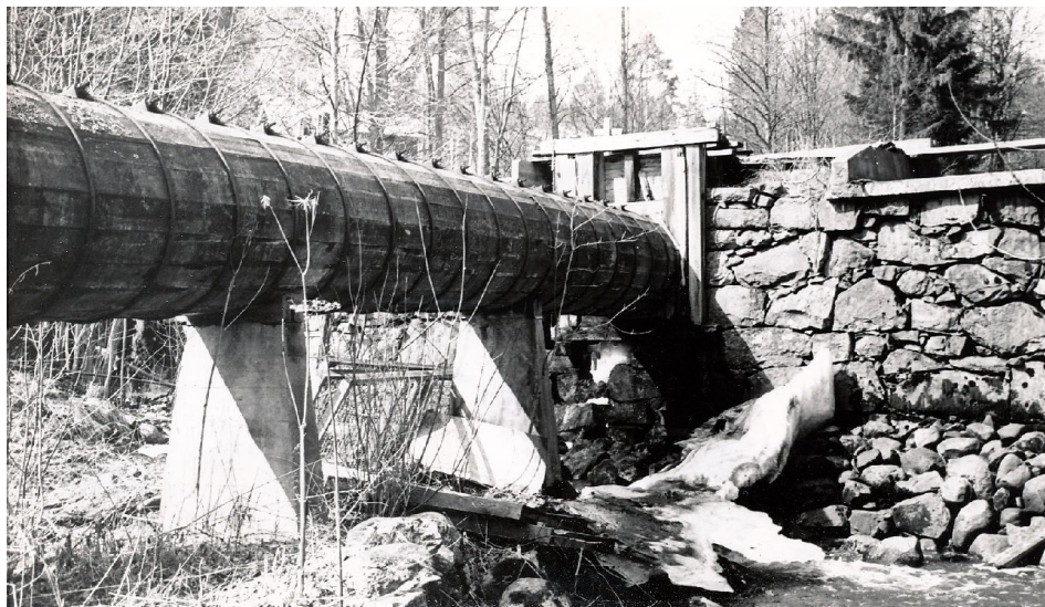
Figur 4. Den så kallade vattentuben ansluten till den plats i vallen som gråfärgats i figur 3. Foto från 1950-talet, i Kvarsebo hembygdsförenings ägo.
