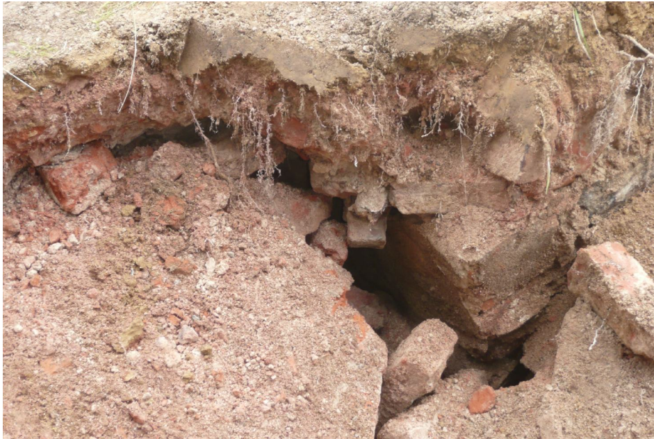
Figur 10. Den igenrasade kanaltunneln visar spår efter slaget tegelvalv vid ingången till kanalen under kvarnen. Foto från norr: Arkeologgrupppen AB.
