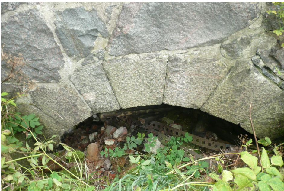
Figur 6. Den valvslagna öppningen till vattenkanalen under kvarnen. Foto från söder: Arkeologgruppen AB.
