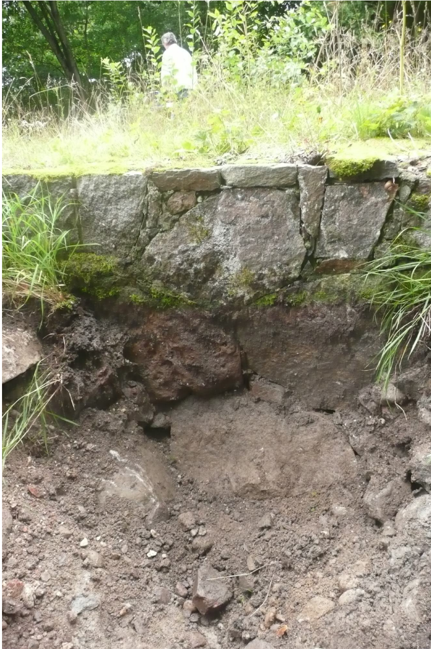
Figur 11. Hela grundmurens djup framtaget i schakt OS502 . Lägg märke till den rundade formen på stenen högst upp i mitten. Det kan röra sig om en återanvänd kvarnsten. Foto från öster: Arkeologgruppen AB.
