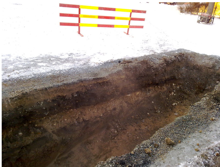
Figur 3. Bild tagen på schaktets södra sida. Foto Ebba Knabe.
