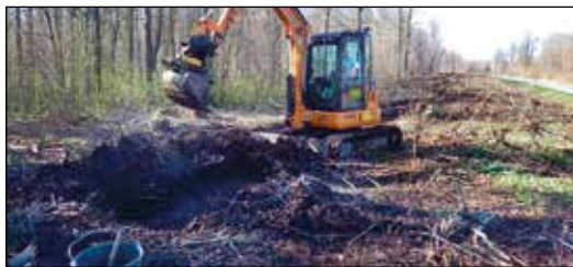
Figur 36. Inom objekt 15 grävdes små schakt inklämda mellan stubbar och djupa hjulspår. Foto från norr.
