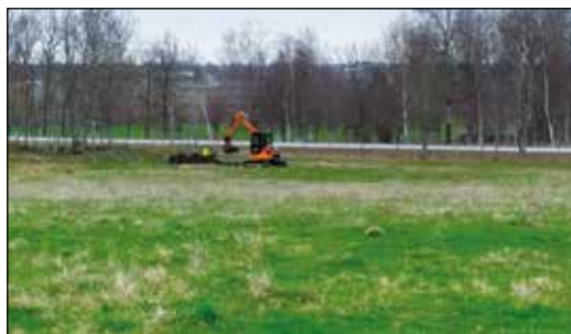
Figur 20. Schaktgrävning i objekt 8, norr om väg 204. Foto från norr.
