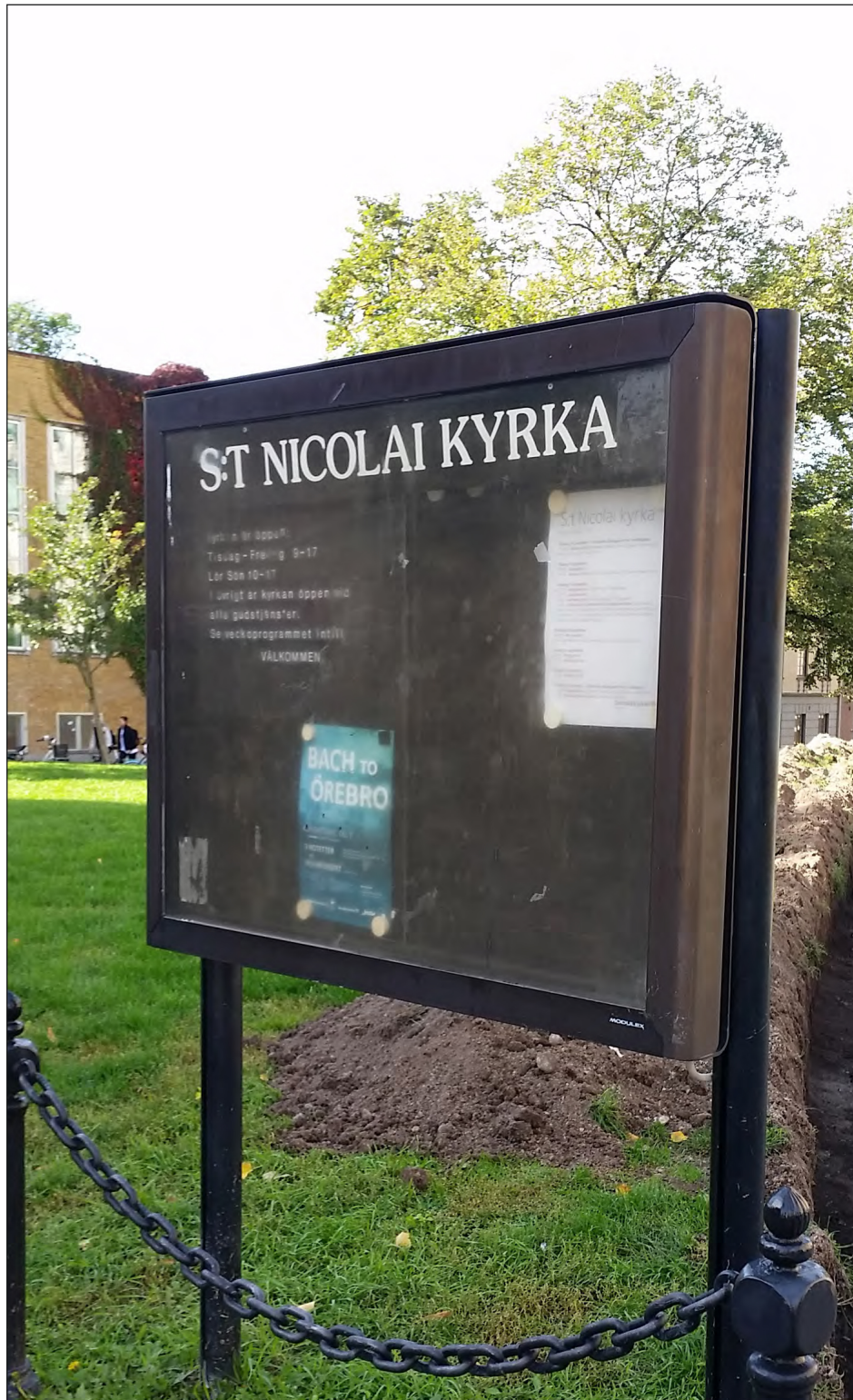
Figur 8. Östra änden på schaktet. Den äldre anslagstavlan ska bytas ut mot en ny digital. Foto från öster.
