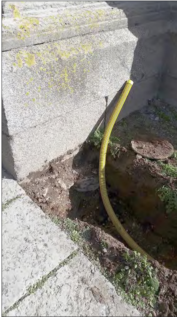
Figur 7. Västra änden av schaktet där kabeln är framgrävd till den västra strävpelare på kyrkans södra sida. Foto från söder.
