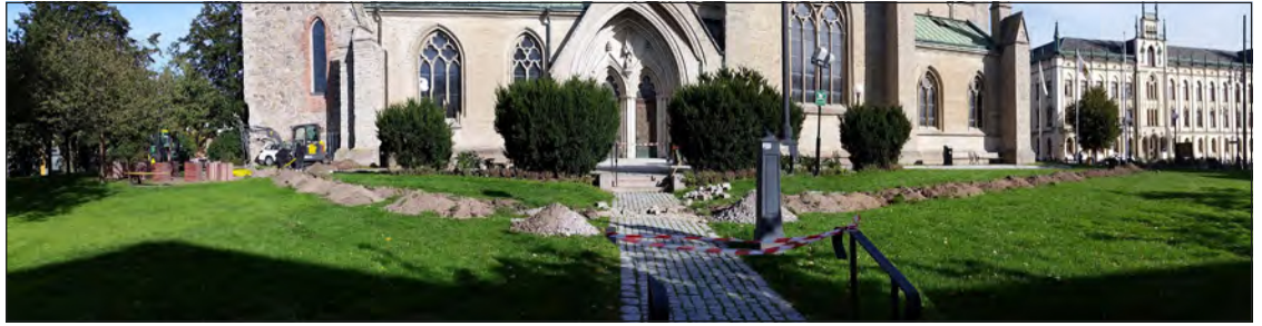
Figur 4. Vy över schaktet som grävdes på södra sidan om Nikolai kyrka. Sammanlagt 58 meter långt och som mest 0,6 meter djupt. Foto från söder.
