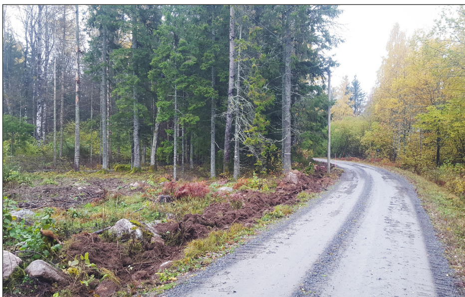
Figur 4. Vy över det grävda schaktet, foto från norr.
