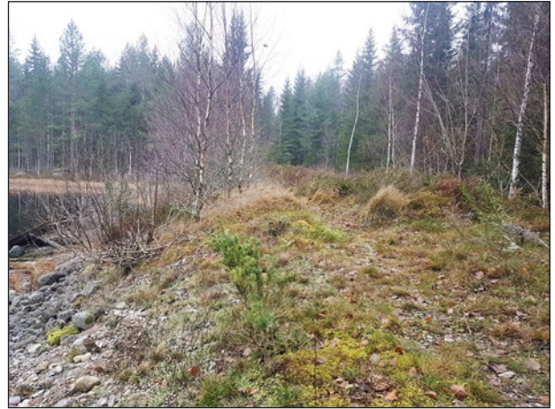
Figur 24. Dammvallen (objekt 2) vid Lilla Gällsjön utgörs av sten och jord. Överst på vallen är en skogsväg. Foto från öster.
