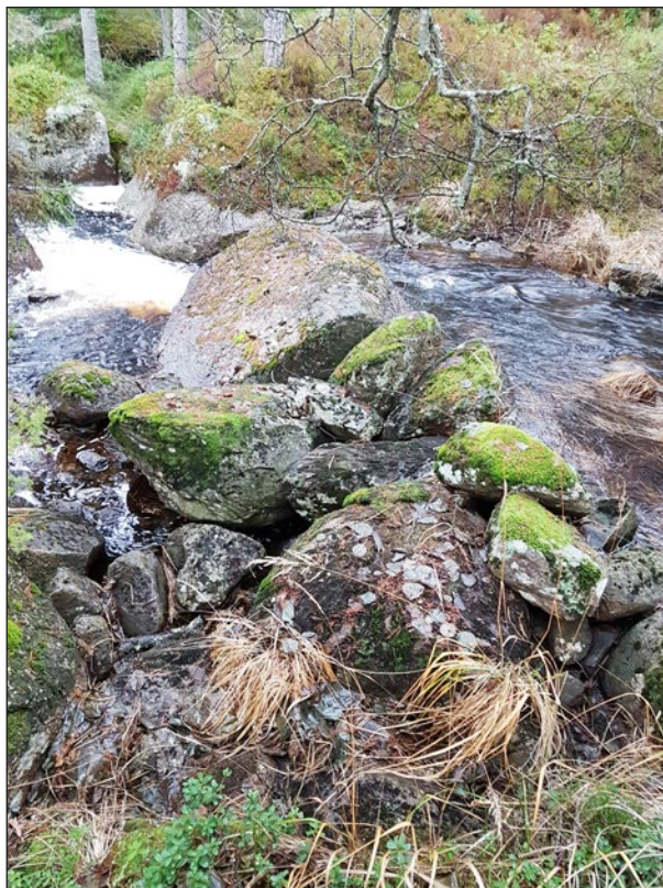
Figur 66. I åns mitt ligger ett naturligt flyttblock vars ena sida dämts upp med ditlagda stenar inom objekt 51. På så vis tvingas timmerstockarna att flyta längs stenblockets södra sida. Foto från norr.
