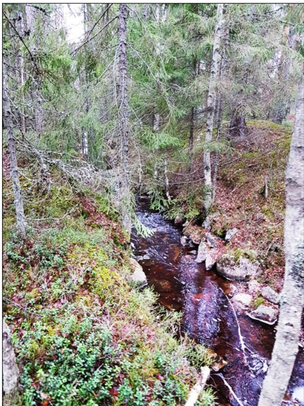
Figur 57. Den grävda rännan, objekt 33 -här med stensatta kanter. Bilden visar även rännan vid dess djupaste parti där den är nästintill 4 meter djup och omges av uppkastade jordvallar. Rännan är grävd genom en tidigare mosse. Foto från sydöst.
