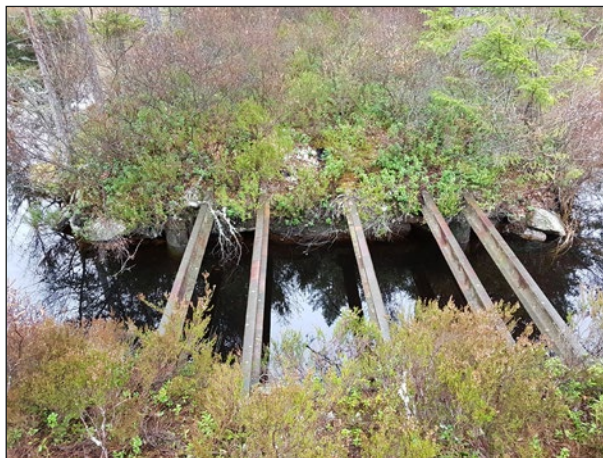
Figur 60. Övertorvade brofästen (objekt 45) av kallmurade stenar. En bro finns markerad på platsen enligt karta från år 1797. Foto från norr.
