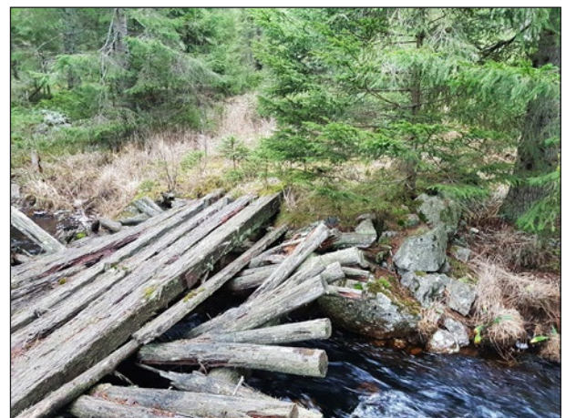
Figur 59. Bro (objekt 41) med kallmurade brofästen. Den leder till en skogsväg mot skogen i öster och har sannolikt anlagts under 1900-talet. Foto från väster.
