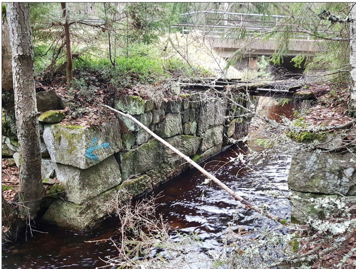
Figur 53. Malmbron (objekt 30) var en bro som hörde till den äldre landsvägen mellan Karlskoga – Grythyttan och förekommer i en karta från år 1757. I bakgrunden ses bron till den moderna landsvägen (väg 275). Foto från väster.
