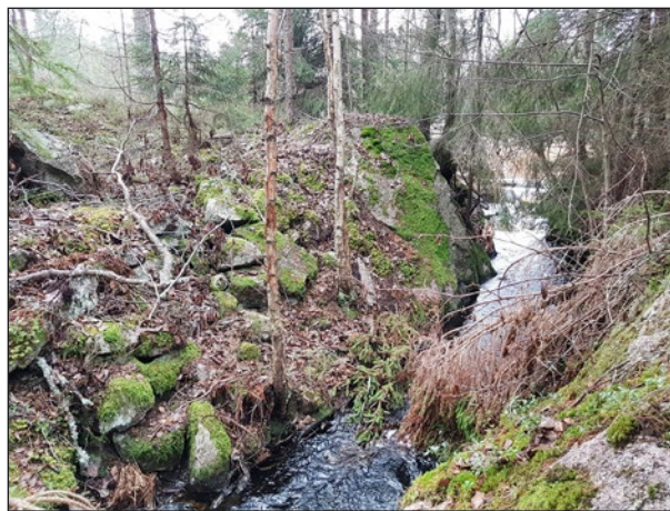
Figur 38. Västra änden av flottningslämning, objekt 15 är smal och omges av höga bergssidor som i skrevorna är fodrade med strandskoning i upp till sju skift. Foto från nordöst.
