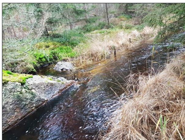
Figur 44. Ledarm inom objekt 22 som avslutas med markfast stenblock. Ledarmen utgörs av stående trästölar med liggande trästockar mellan stöarna, under vattenytan. Foto från nordöst.
