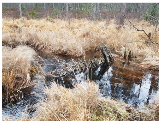
Figur 46. I nordvästra änden av den grävda rännan inom objekt 24 ses en dammvall bestående av resta stockar som spärrar av den "U-formade" åkröken. Foto från öster.
