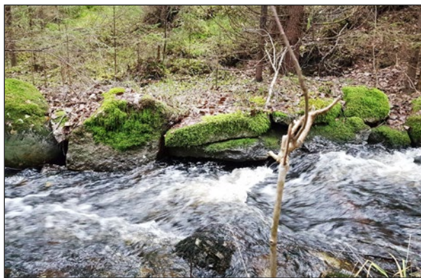
Figur 39. Vällagd strandskoning längs objekt 15. Här ses stenarna utgöras av skoning i 1-2 skift med oregelbundna skift och med flat sida vänd mot vattendraget. Foto från norr.
