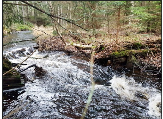
Figur 56. Dammvall, objekt 32, med liggande stockar i vardera åkant. Här har en dammlucka tidigare funnits. Genom att stänga av det naturliga flödet har vatten avletts mot den grävda rännan, objekt 33. Foto från norr.
