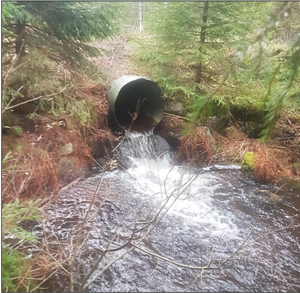
Figur 23. Metallrör genom dammvallen (objekt 1) vid sjön Trehörningen. Foto från nordöst.
