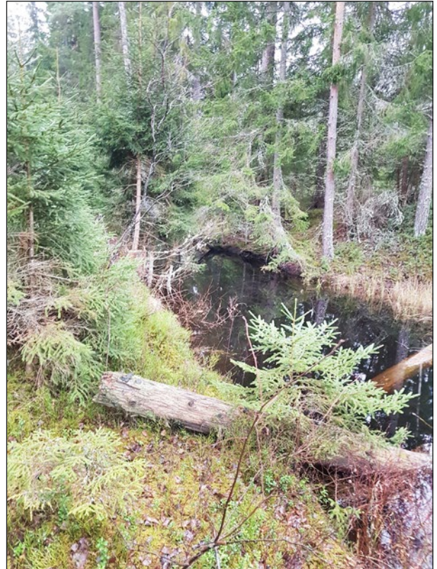
Figur 62. Den grävda rännan (objekt 47) sydöst om Tvärådammen. Via rännan har både vatten och timmer kunnat föras till Karlsdals hytta. Foto från nordöst.
