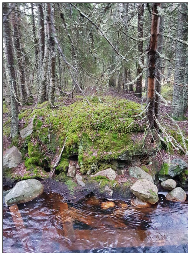
Figur 41. Östra dammvallen (objekt 5) sedd från väster.
