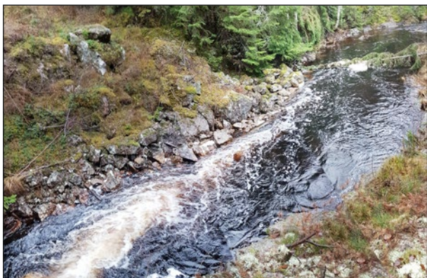
Figur 64. Nedanför stupet trycker vattnet på mot den östra åstranden där en stenkista (objekt 25) anlagts för att hindra timmer från att fasta mellan större stenblock. Foto från väster.
