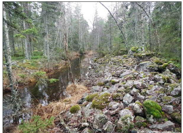
Figur 39. Släntmur längs Sångarebäcken. nedströms dammvallen (objekt 3), som utgörs av bortrensade stenar från bäcken. Foto från norr.
