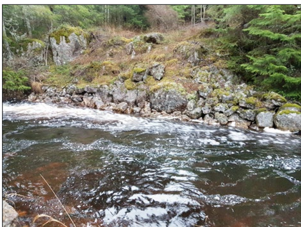
Figur 65. Stenkistan (objekt 25) anlagd mellan berghällar och stenblock. Foto från sydväst.
