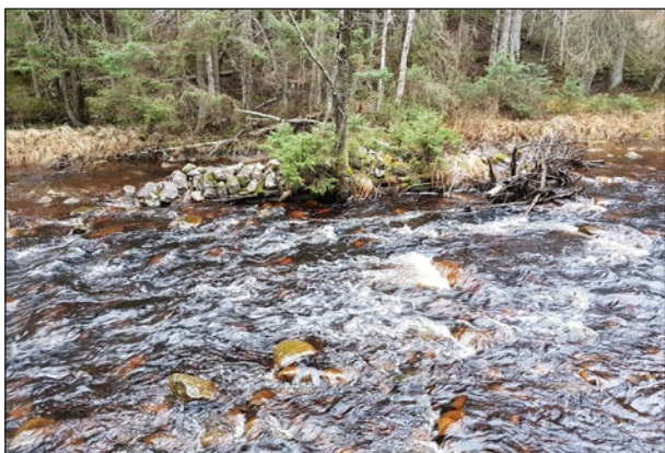
Figur 74. Där ån är vid och grund har en stenkista anlagts (objekt 46) i åns mitt för att hålla timret flytandes i den djupare delen av ån. Foto från sydöst.
