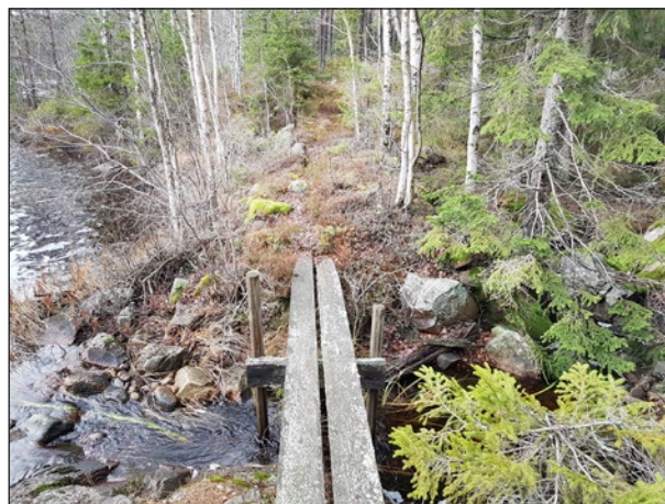
Figur 53. Foto över den västra dammvallen (objekt 16) sedd från öster. Dammvallen utgörs av jord och sten.
