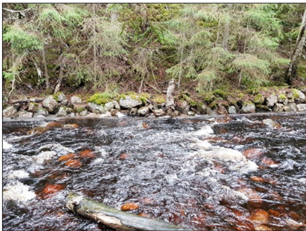
Figur 70. I en skarp yttersväng har en stenkista (objekt 40) anlagts då den naturliga åkanten varit alltför grund med risk för att stockar fastnat. Foto från öster.
