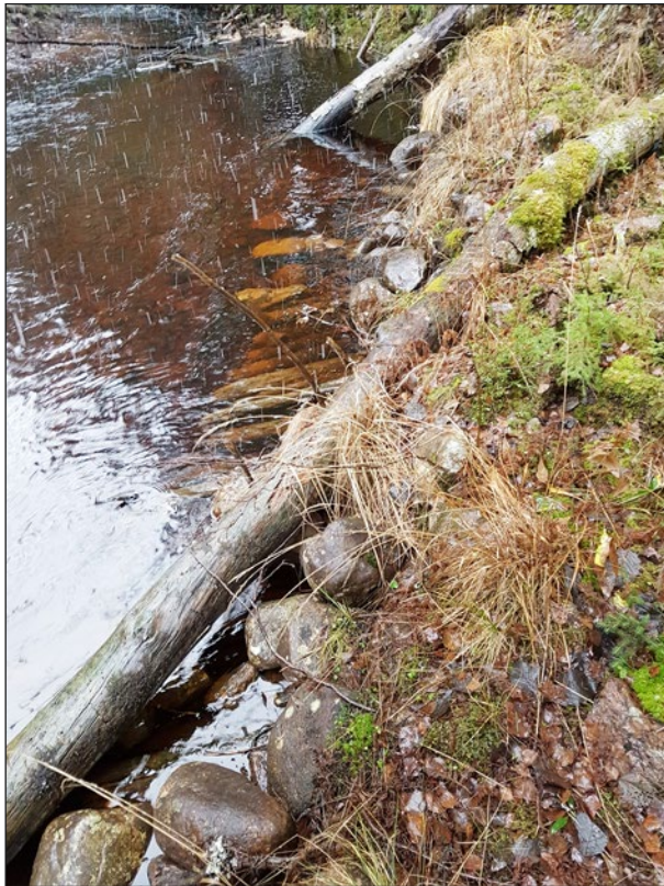
Figur 72. Den i ån anlagda stenkistan (objekt 42) vilar på en matta av utlagda stockar. Stockarna kan här skönjas i åbotten bredvid stenkistan. Foto från sydväst.
