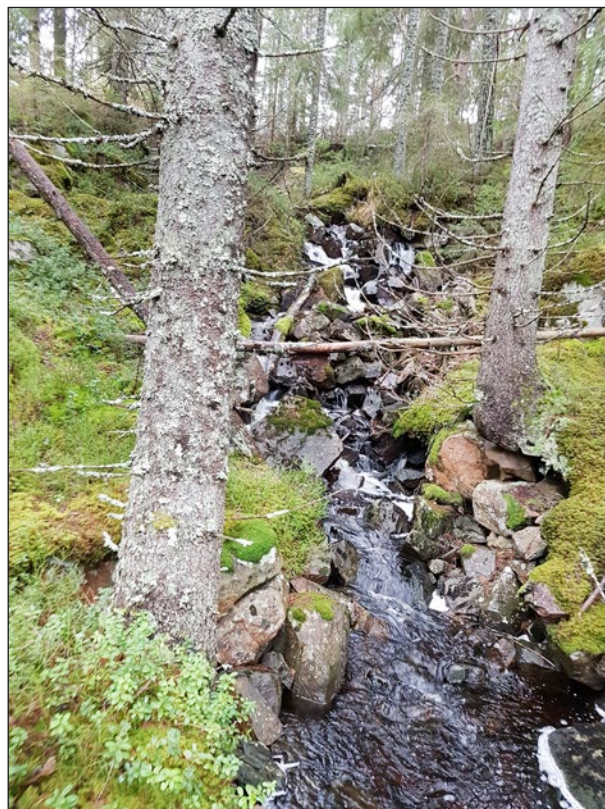
Figur 57. Vid granstammarna ses det norra väggfundamentet till kvarngrunden (objekt 16). Fundamentet är kraftigt övertorvat och ses endast i bäcksidorna. I bilden ses att byggnaden varit öppen där vattnet flödat genom grunden. Sannolikt har ett skovelhjul funnits inne i byggnaden. Foto från nordöst.
