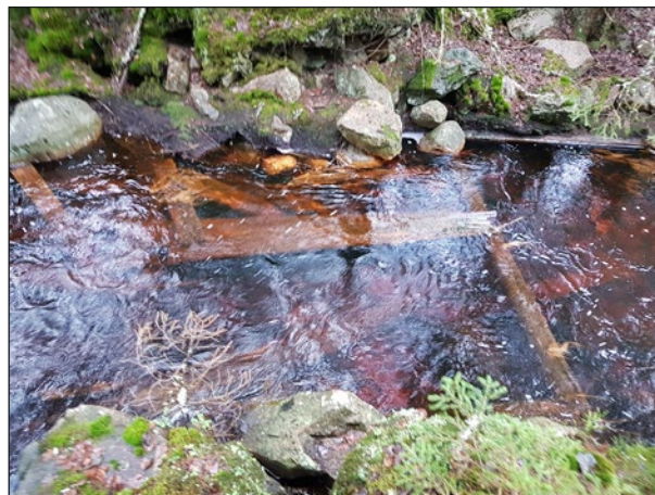
Figur 43. I bäckens botten i dammvallens öppning ses en nedrasad träkonstruktion från dammen. Foto från väster.
