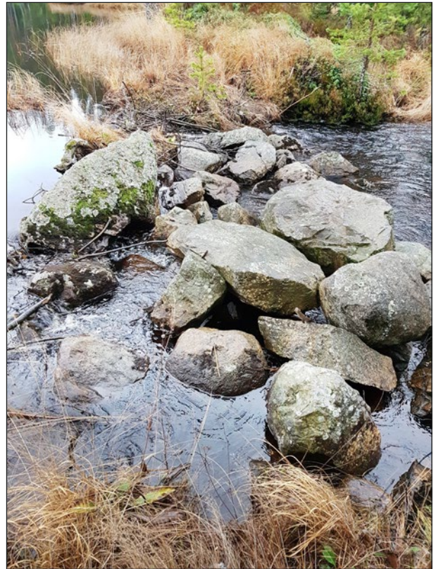
Figur 51. I Övre Sandtjärnens utlopp i Sandån ses ett flertal större stenar ligga tvärs över öppningen. Sannolikt är de äldre fyllning i stödkistor som fungerat som stöd åt dammen. Stödkistornas fyllning har rasat ut sedan timmerkistorna bortruttnat. Foto från väster.
