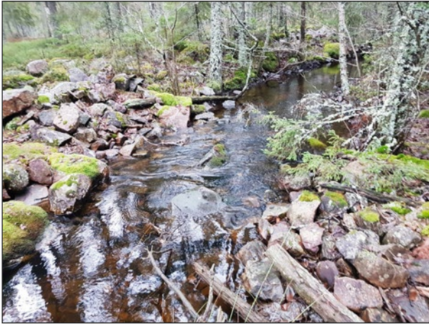
Figur 37. Dammvall (objekt 3) strax nedströms sjön Sångarens utlopp i Sångarebäcken. I vardera sida om bäcken är raserade stenkonstruktioner efter en äldre dammlucka. Dammen beskrivs som gammal åren 1912–13 och rustades under denna tid upp. Foto från nordväst.
