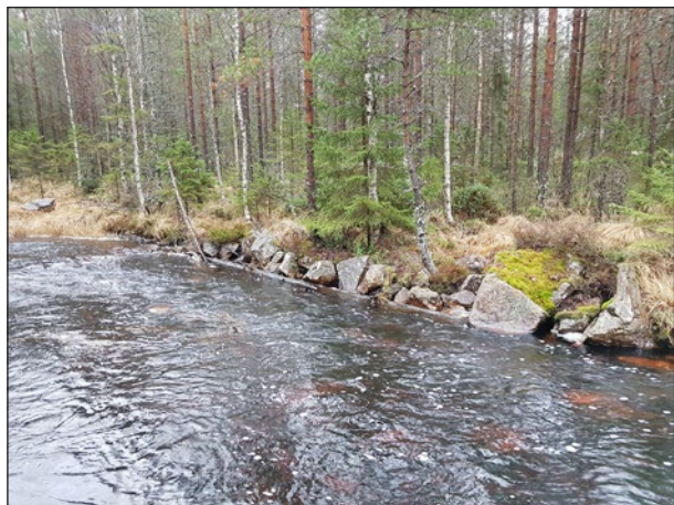
Figur 52. Stenkista som anlagts i sankt parti vid åkrök för att förhindra timmer från att fastna i den sankta strandzonen. Foto från nordväst.
