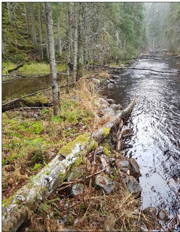
Figur 71. I en skarp åkrök har en stenkista (objekt 42) anlagts framför en inbuktning i ån där risk funnits att timmer fastnat i inbuktningen. Foto från öster.
