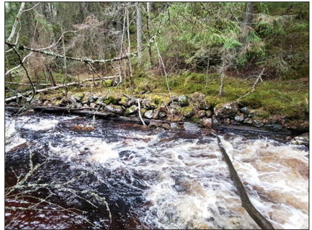
Figur 73. I ett forsande parti har en stenkista (objekt 44) anlagts där vattnet trycker på mot åkanten i yttersvängen. Utan stenkistan hade stockarna fastnat emot strandkanten. Foto från öster.
