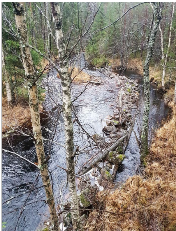
Figur 66. Stenkista (objekt 27) anlagd framför inbuktning i åkrök i. Foto från norr.
