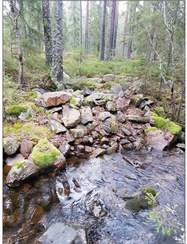
Figur 38. Raserad dammkonstruktion (objekt 3) i östra bäcksidan. Ytterst utgörs stenkonstruktionen av kallmurade ytterväggar vars insida fyllts igen med stenmaterial, sannolikt sedan en ursprunglig träkonstruktion har ruttnat eller rivits bort. Foto från väster.
