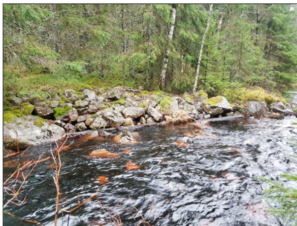
Figur 61. Uppströms "Lillstupet" är en stenkista som leder timret ned till stupet. I stupet finns berghällar som visar spår efter att ha sprängts. Foto från nordväst.
