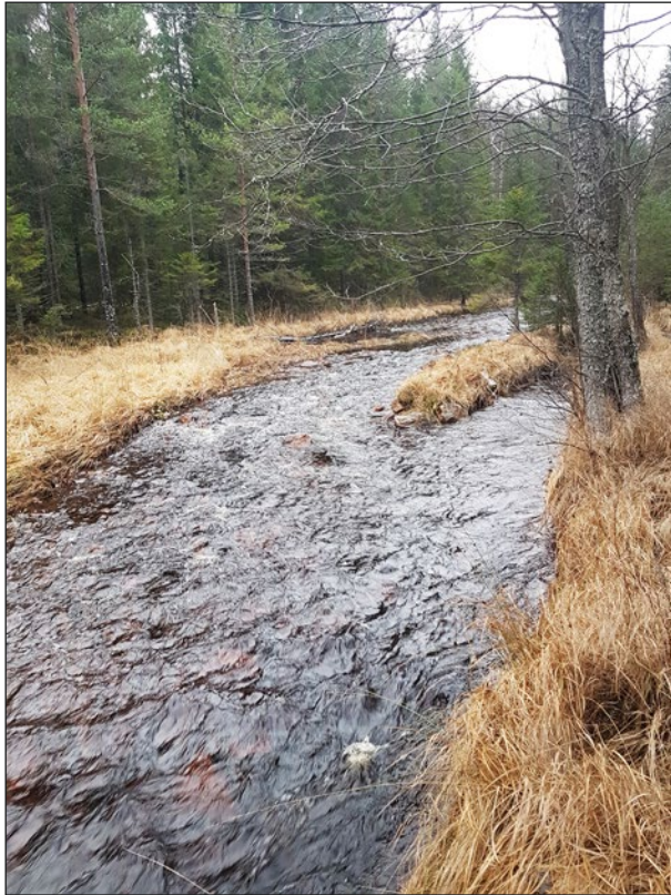
Figur 69. Vattenledare (objekt 35) anlagd i åns mitt, för att hålla timret i djupare del av ån. Foto från sydöst.
