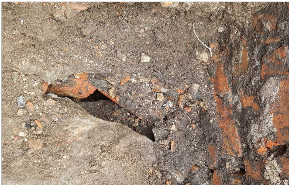
Figur 12. Håligheter under K2.
