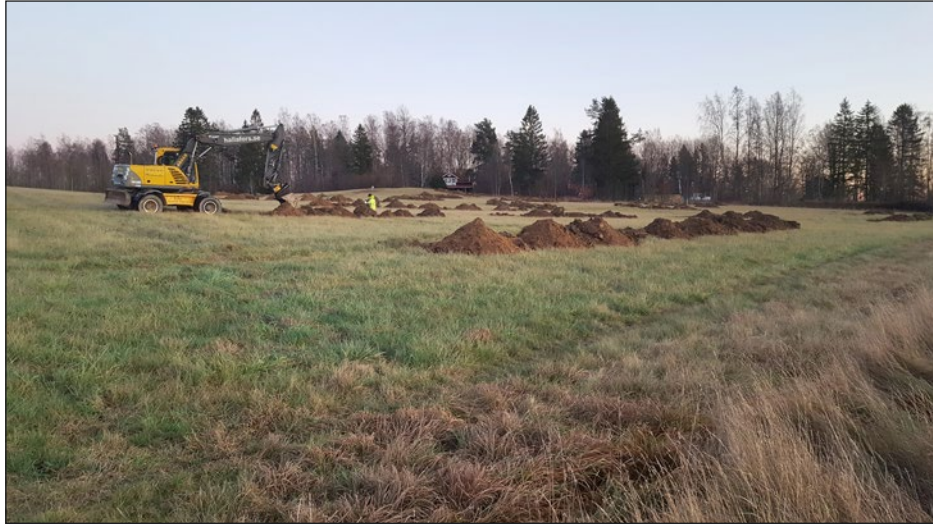
Figur 4. Vy över södra delen av området med grävda schakt. Foto från nordväst.
