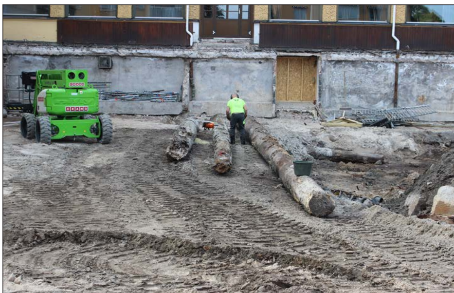
Figur 14. Stockar från rustbädden plockades upp. Prov för dendrodatering sågas.
